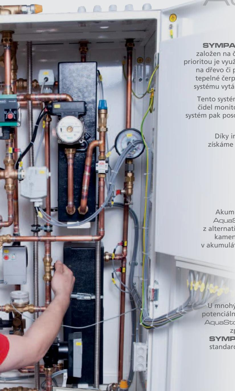
**SYMPATIK®** AquaStorage je moderní systém vytápění, který je založen na čerpání energie z různých tepelných zdrojů. Jednoznačnou prioritou je využívání těch alternativních (solární energie, zplyňovací kotel na dřevo či pelety, krb nebo krbová kamna s teplovodním výměníkem, tepelné čerpadlo). Nadřazený řídící systém optimalizuje funkci daného systému vytápění a přípravy teplé vody s prioritou ekonomiky provozu.
