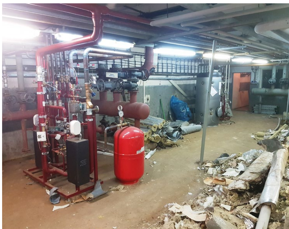
Rekonstrukce výměňkové stanice pavilon G
