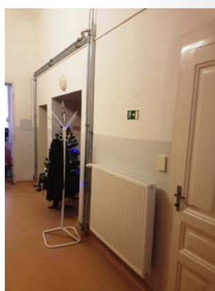
Jeden z 1 536 radiátorů měněných za plného provozu
