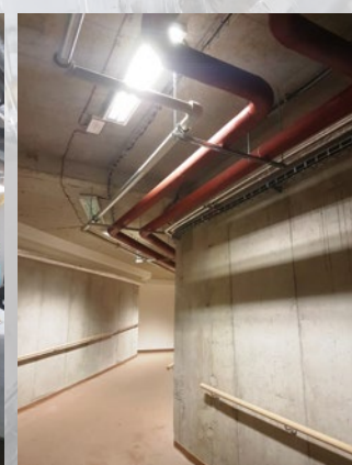
Potravní trasa nového teplododního rozvodu pavilon N
