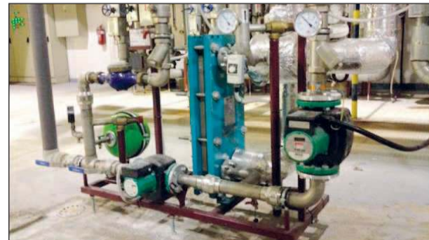
První instalace výměníku MODhex® byla provedena v roce 2011. Modul byl instalován v Aquacentru Most jako jednotka pro ohřev teplé vody. Výměník MODhex® nahradil původní pájený deskový výměník, který bylo nutné pravidelně po 1,5 roku měnit z důvodu vnějších netěsností.
