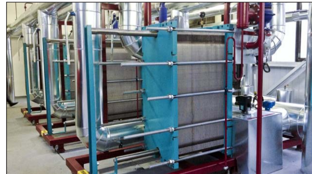
Aplikace s vysokým požadavkem na provozní spolehlivost. Předávací stanice s výměníky MODhex® 22 MW
